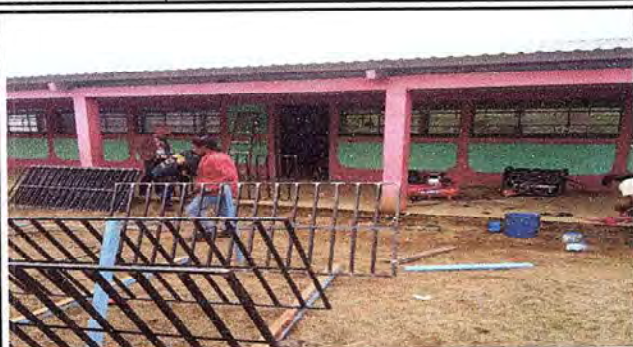
Foto 1: Vista de trabajo en proceso
