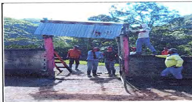
Foto 5: Trabajo en proceso de reparación del portón
