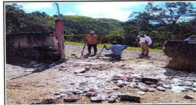
Foto 6: Vista de trabajo de la entrada principal y muro perimetral por los padres de familia
