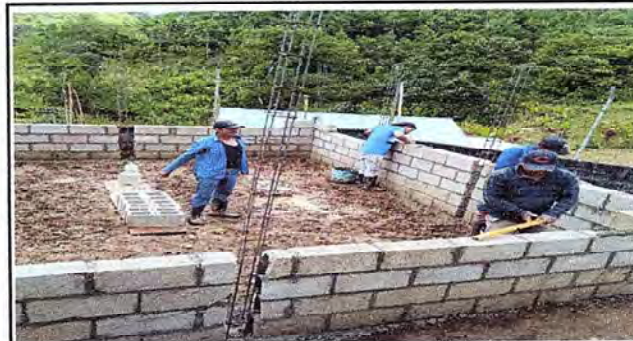
Foto 4: Trabajo en proceso de la cocina
