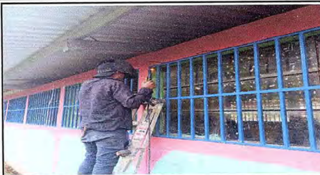
Foto 2: Vista de colocación de balcones
