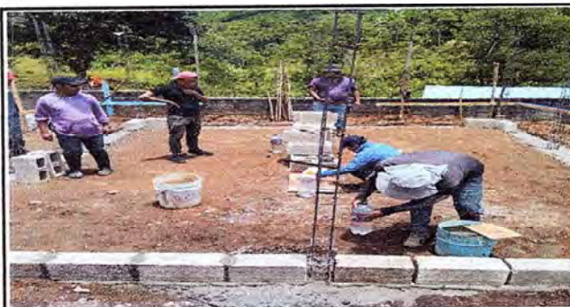
Foto 3: Sustitución de paredes de cocina debido a que se constato que por los años ya no se encontraban bien las mismas
